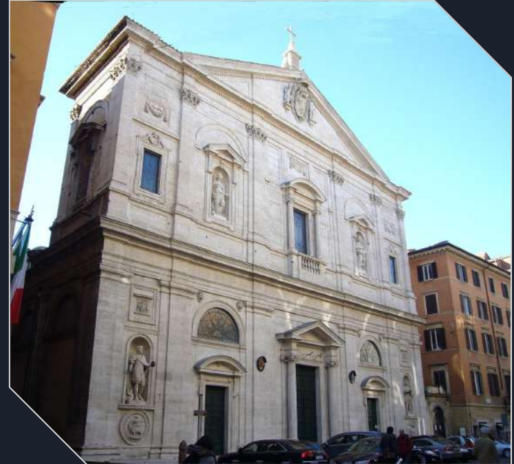
-FACCIATA DELLA CHIESA DI S. LUIGI DEI FRANCESI-
